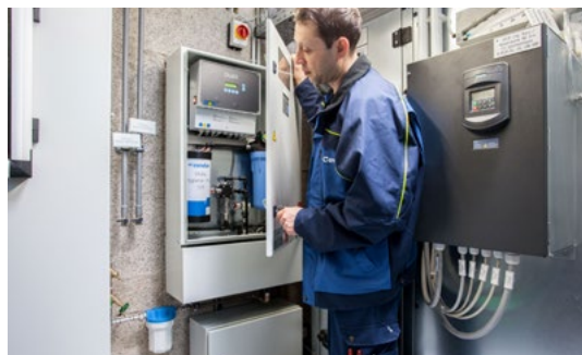
Funktionsprüfung der Befeuchtungseinrichtung.
